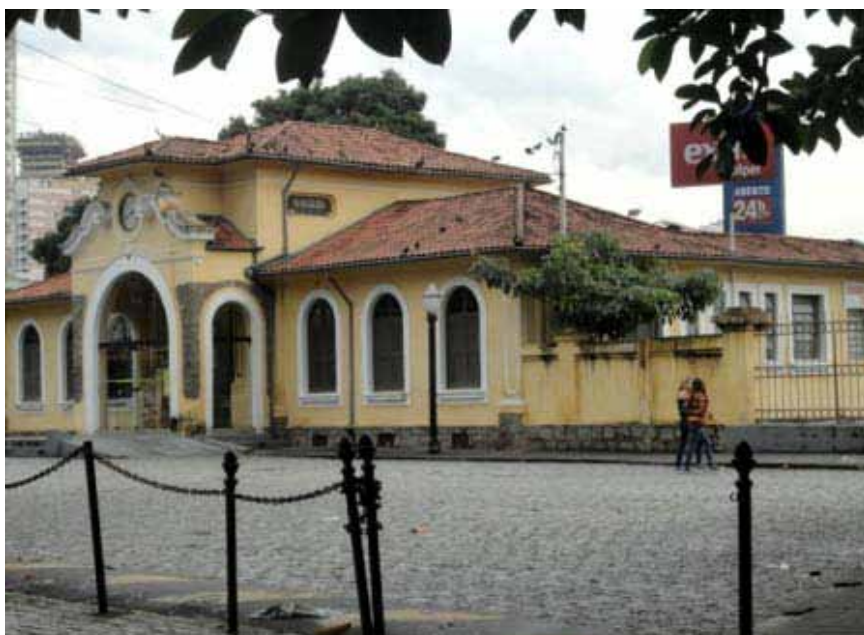
Figura 3 – Faixada da Estação da Cidadania e Cultura (Fonte: Maira Begalli em 10/07/2012).
